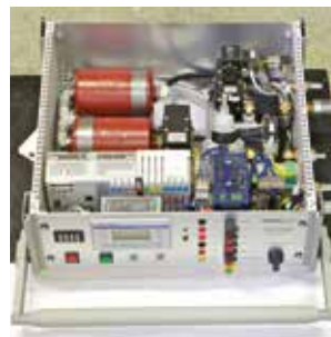
Панель управления с электронно-пневматическими компонентами.
